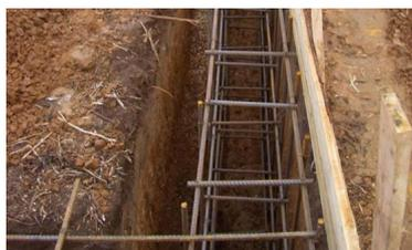
Ленточные фундаменты подводят под дома с тяжелыми стенами (бетонными, каменными, кирпичными и т. п.) или с тяжелыми перекрытиями. Их закладывают под все наружные и внутренние капитальные стены. Наличие под домом подвалов, теплых подполий, гаража или цокольного этажа делают просто необходимым выбор именно этого типа фундамента.
